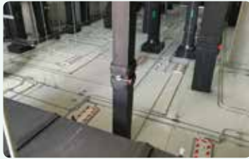
可承重及带有维修通道的技术夹层，可降低维修人员的高坠风险
